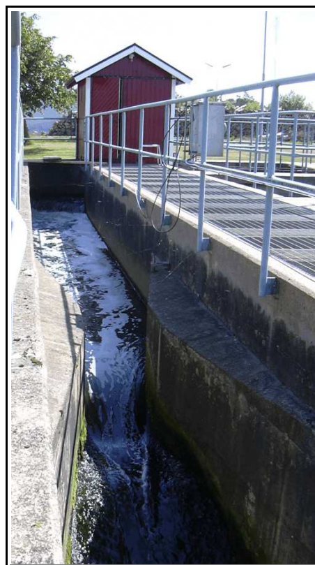
Ränna för flödesmätning på utgående vatten. Givaren sitter strax innan förträngningen och fallet. I boden i bakgrunden finns provtagningsutrustningen som visades på föregående bild. Foto L Lind
