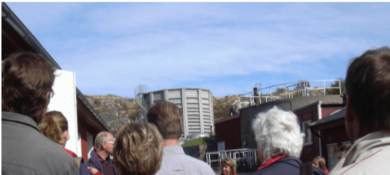
Skärhamns avloppsreningsverk. Runda byggnaden i bakgrunden är en biobädd
