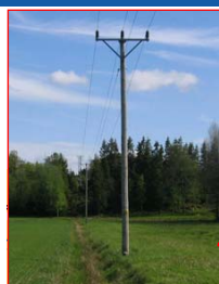
10 kV lokalnät (mellanspänningsnivå)
