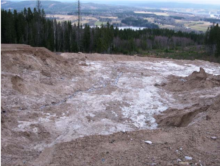
Felaktig hantering av massor. Det myckna regnandet i november underminerade massorna och ett flertal tusen ton gav sig iväg utför
