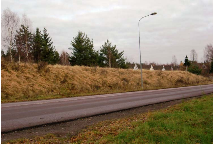
Bullervall som byggts av återvunna massor
